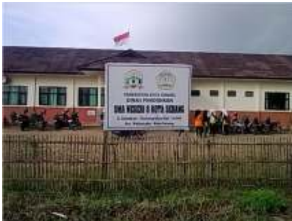
Gambar 2 Gedung Depan Sekolah, Maret 2016
