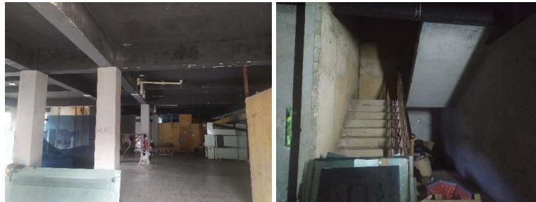
Gambar 9. Kondisi Struktur Eksisting Objek Penelitian (Sumber: Peneliti, 2022)
