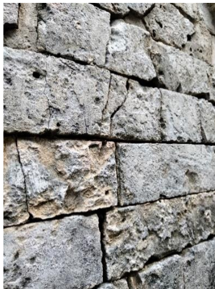
Gambar 4. Tekstur material Batu Karang pada Candi Kurung di Pura Sakenan (Sumber: Salain, NRP, 2022)
