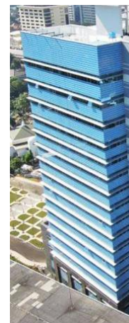
Gambar 5. Penerapan Horizontal Sun Shading di Gedung PUPR - garis horizontal warna putih pada gambar
