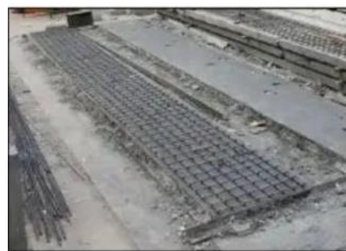
Gambar 10. Penggunaan Waste Material Besi pada Pekerjaan Non Struktural
