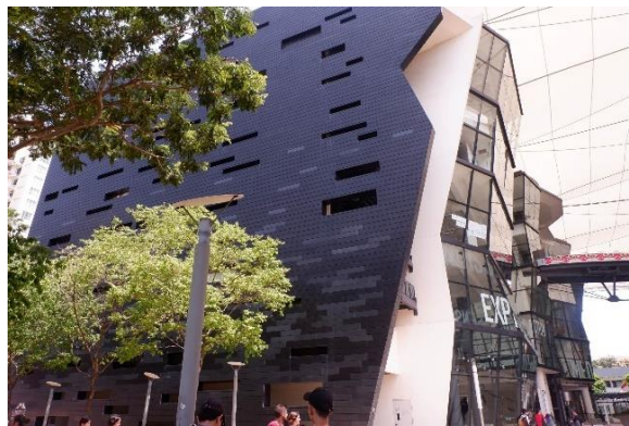
Gambar 12. Secondary Skin pada Fasade Kampus Lasalle untuk Kajian Teori Suhu dan Pencahayaan (Sumber: Dokumen pribadi, 2021)
