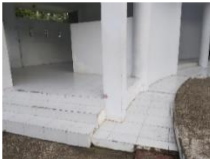
Gambar 12. Kondisi aksesibilitas mushola (Sumber: dokumentasi pribadi, 2021)
