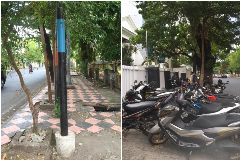
Gambar 1. Kondisi Jalur Pedestrian di Jalan Jend. Sudirman Kota Makassar. Jalur terhalang oleh tiang listrik, pohon, dan lubang bekas galian (kiri); Jalur terhalang oleh parkir (kanan) (Sumber: Dok. Penulis, 2020).
