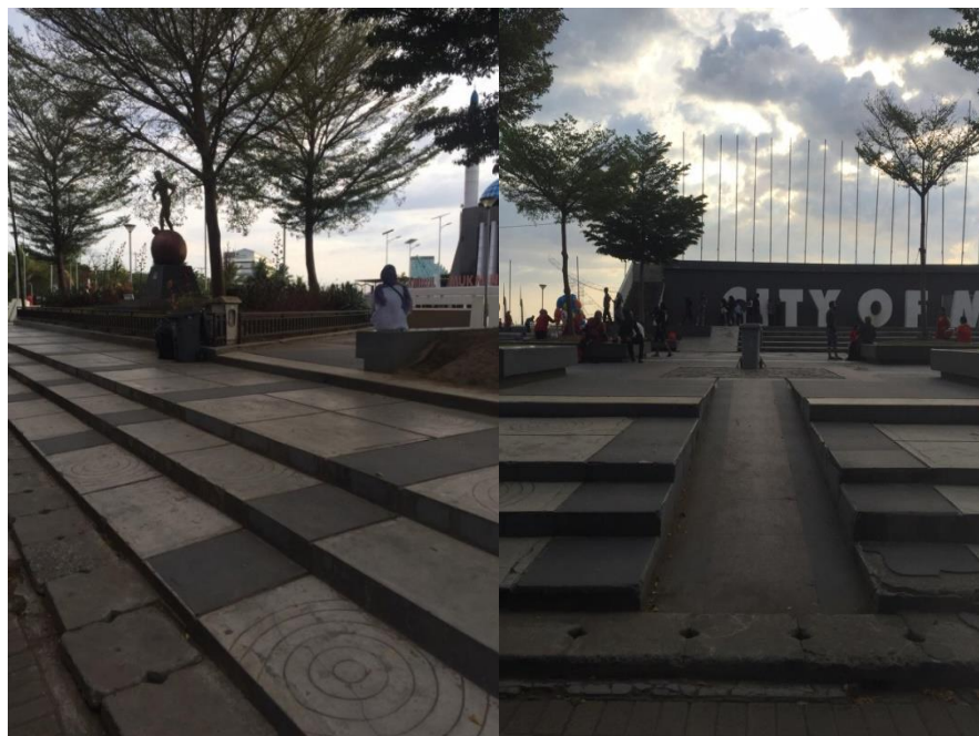
Gambar 2. Kondisi Pantai Losari di Kota Makassar. Lantai yang berundak-undak mengganggu difabel (kiri); Ram yang tersedia sebagai jalur difabel (kanan) (Sumber: Dok. Penulis, 2020)
