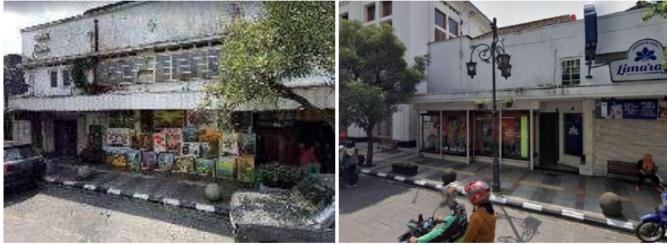
Gambar 15. Kanopi di Beberapa Titik Jalan Sumber: Google Street View, 2019
