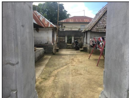
Gambar 5. Sanggah/Tempat Suci dengan Ruas Jalan Membujur dari Timur ke Barat (Sumber: Widiyani, 2020)
