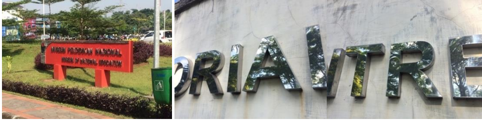
Gambar 8. Penanda dengan tulisan dari stainless stell dengan finishing chrome dan bersifat reflektif.
