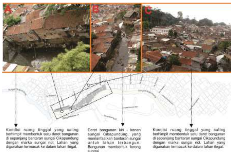
Gambar 6. Kondisi Kualitas Bangunan di Kawasan Balubur Tamansari Kota Bandung Sumber: Modifikasi hasil Survey Peneliti tahun 2011 - 2018
