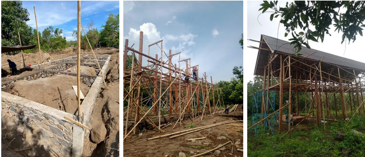
Gambar 5. Proses Konstruksi Bangunan Sekolah Informal di Desa Tulamben
