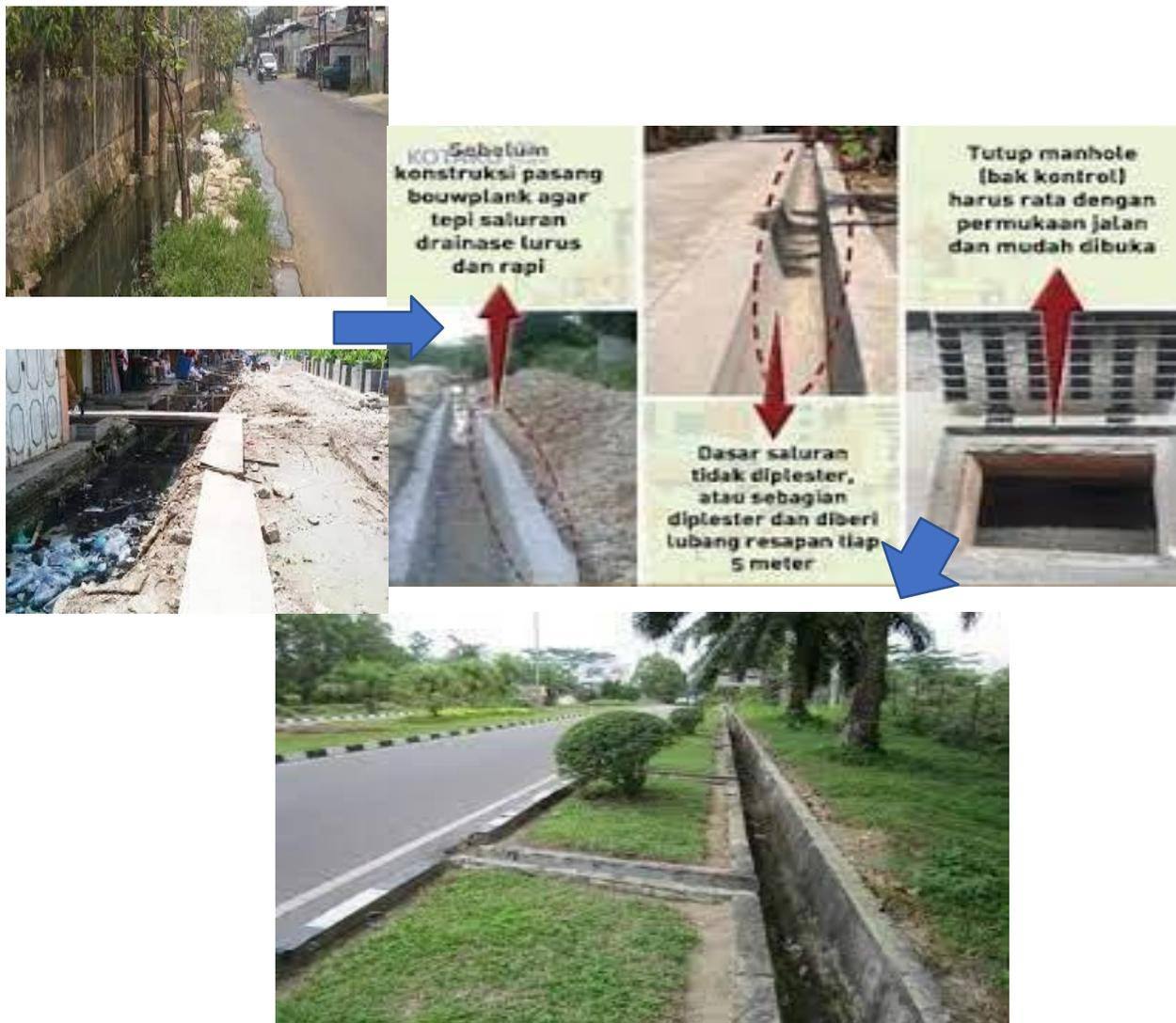
Gambar 10. Pemenuhan standart pemeliihaaraan Drainase / saluran Tepi Jalan
