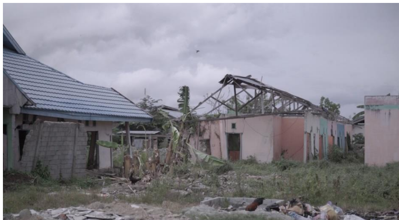
Gambar 2: Sisa kerusakan yang diakibatkan gempa dan likuifaksi sesar Palu Koro Sumber: Dokumentasi Peneliti, 2021
